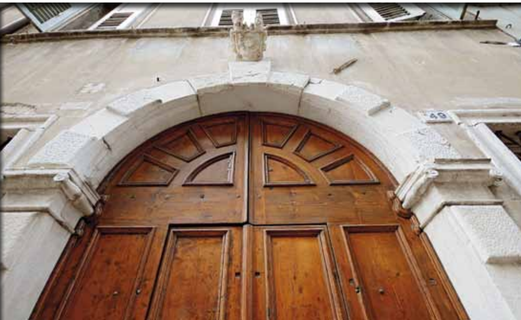
Alloggi di via della Terra,49 - Rovereto
