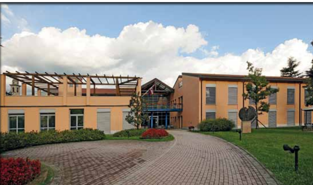
R.S.A.di via Fedrigotti, 7 - Rovereto (Borgo Sacco)
