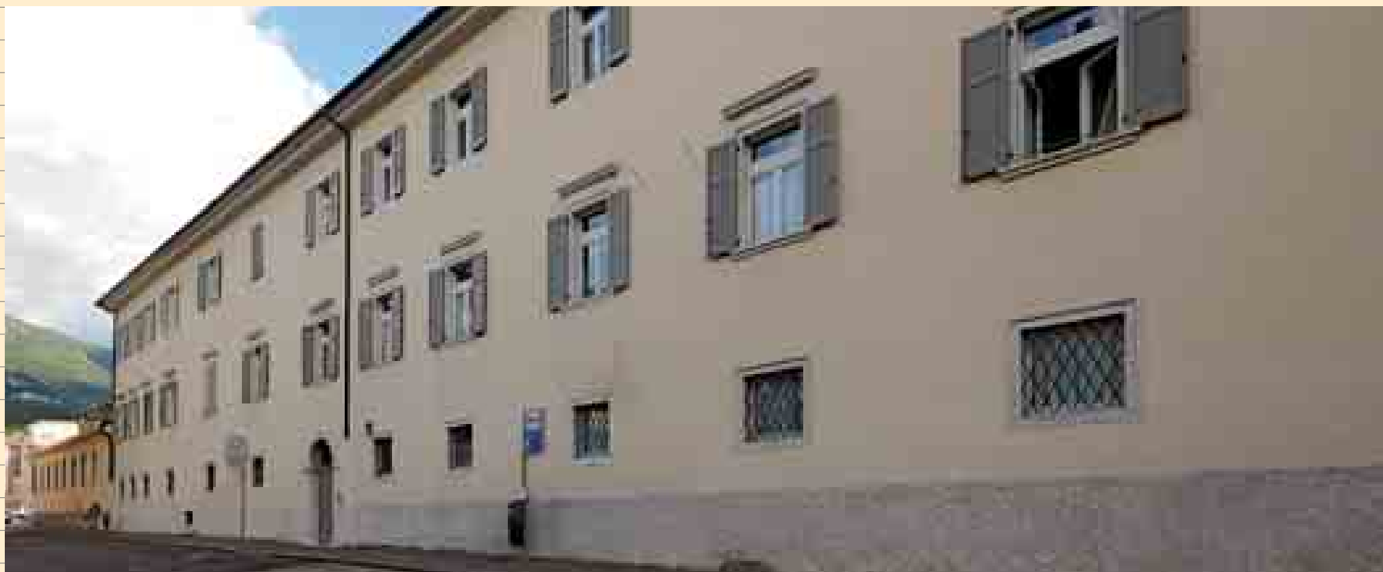
CENTRO DIURNO PER ANZIANI E ALLOGGI PROTETTI di via Vannetti,2 - Rovereto
