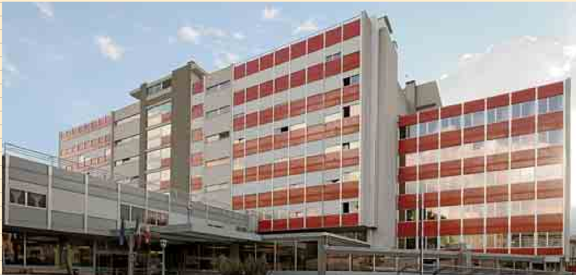
R.S.A. di via Vannetti, 6 - Rovereto
